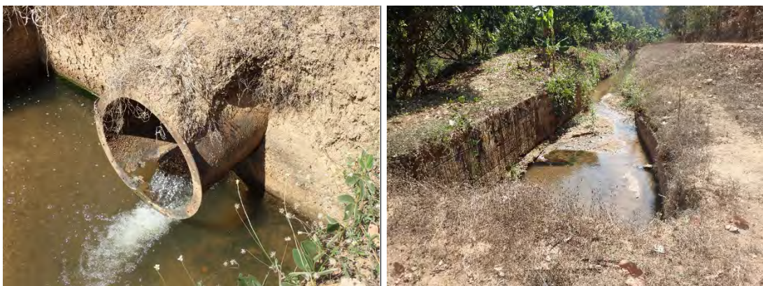
รูปที่ 41 ปลายท่อส่งน้ำเชื่อมต่อกับรางลำเหมืองในจุดสำรวจที่ 24
